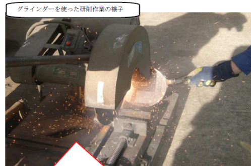
グラインダーを使った研削作業の様子
